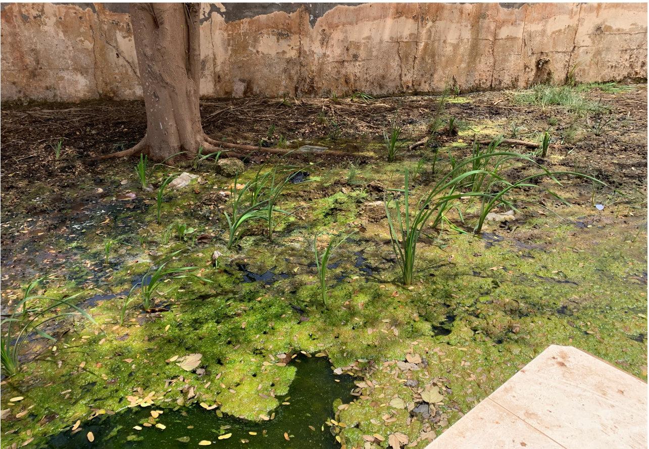
Estado inicial de la zona de psicomotricidad
